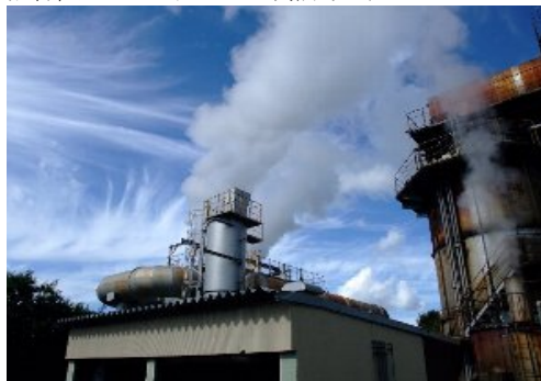
焼却施設からの排煙 施設からの排煙は、フィルターやスクラバーで中和・無害化処理をされている水蒸気のみ
